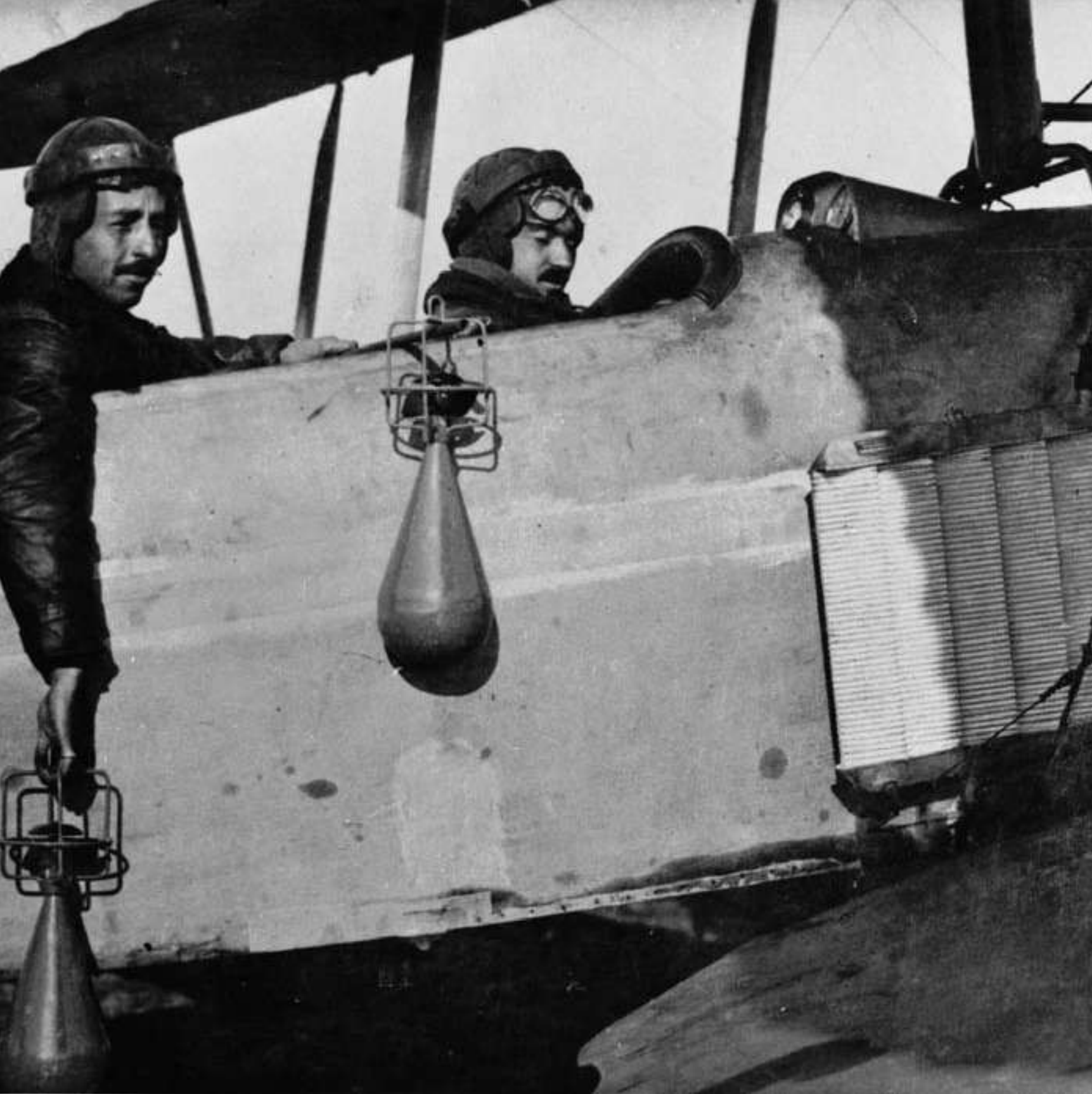
Detalle de la forma del lanzamiento de las bombas Carbonit diseñadas para su lanzamiento desde un Lohner Pfeilflieger por los capitanes Barrón y Cifuentes.
