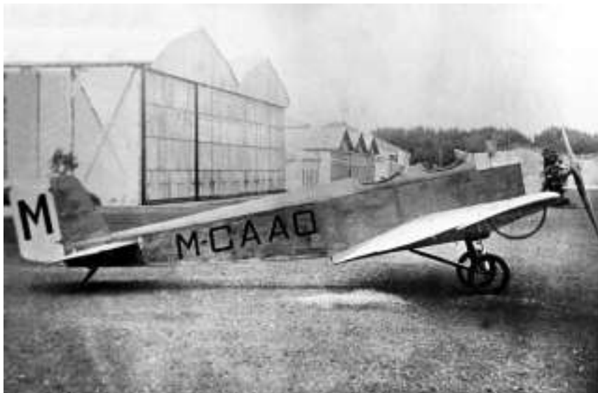
La Klemm L.25 M-CAAO con motor Salmson de 40 HP, que pertenecía al vallisoletano Augusto Zatarain
