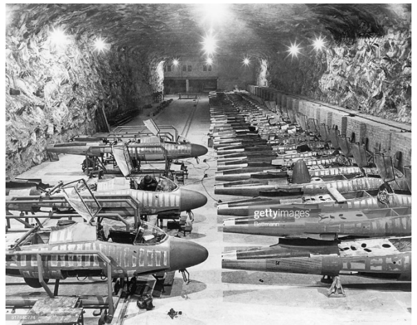
Figura 1: fábrica de producción subterránea en Stassfurt, cerca de Magdeburgo, donde se producía el motor BMW 003.
