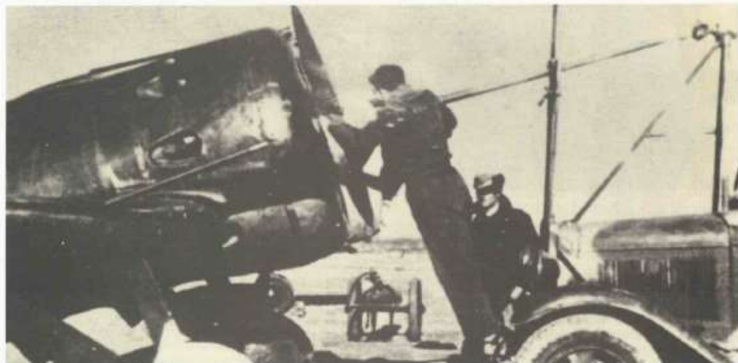
Característico sistema "Hucks" de arrastre por trípode en el pivote de la hélice, común a todos los I-16 rusos. En la imagen, un tipo 10 lo utiliza mostrando su buje corto y redondeado en su extremo.
