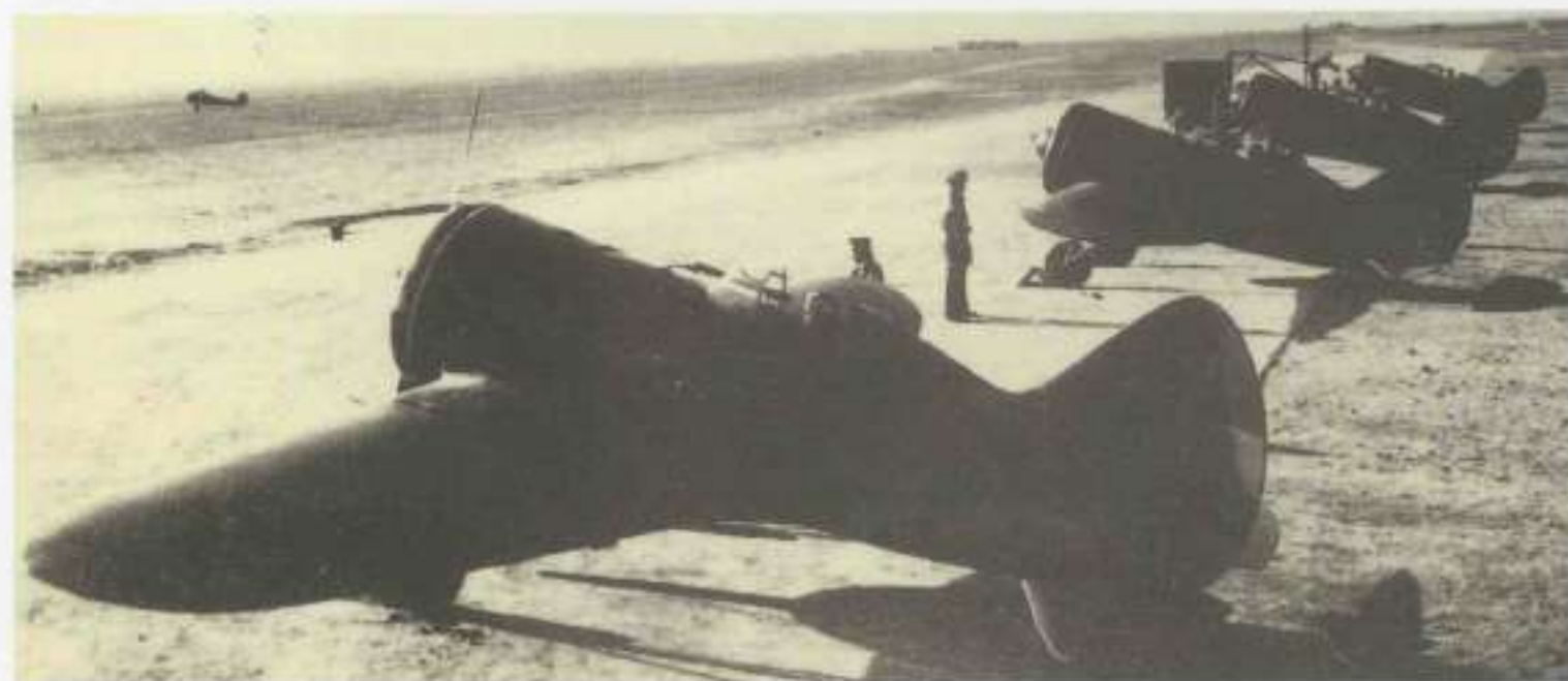
Bellísimo plano de un I-16 tipo 6 de segunda generación, es decir con mira reflectora, de la Fuerza Aérea Soviética. Destacan su "limpieza" de morrión al carecer de ametralladoras de capó y la recién inaugurada cabina abierta con el pequeño y definitivo parabrisa semicircular.
