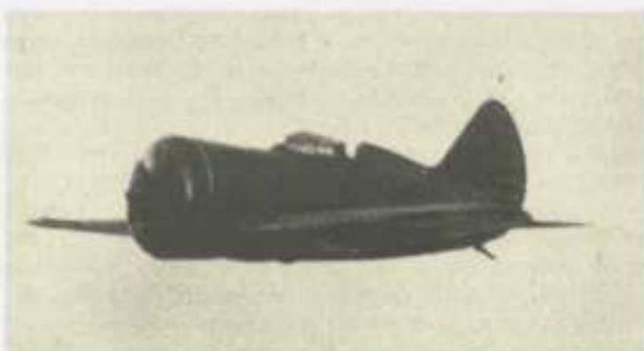
Un tipo 5 en vuelo con la cubierta de la cabina corrida hacia adelante, práctica muy utilizada para mejorar la visibilidad del piloto.
