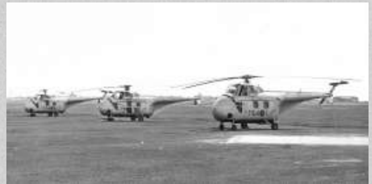
De derecha a izquierda: Z.1C-15 (754-1), Z.1C-23 (754-5) y Z.1C-24 (754-6), en su base de Cuatro Vientos. Obsérvese que el Z.1C-23 carece del estabilizador vertical. Fuente: CECAF
