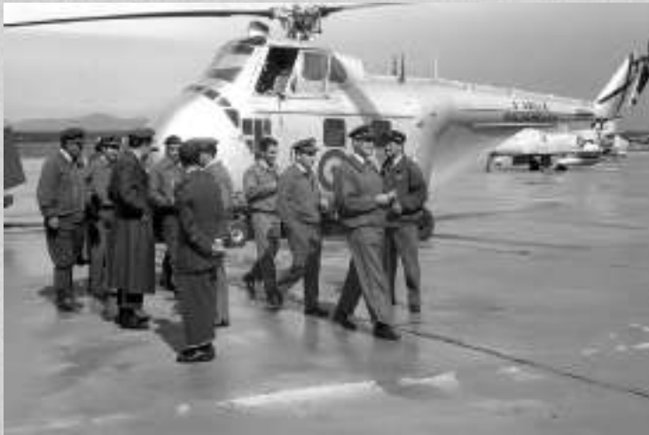
Aquí aparece el Z.1-1, en Manises, en una pausa durante la triste jornada del 14 de octubre de 1957, cuando el desbordado Turia asoló la ciudad de Valencia. Obsérvese que el tres del número de la Unidad de Salvamento de Getafe ha sido borrado, para sustituirlo por el siete. Fuente: AHEA 161 (13) DIG
