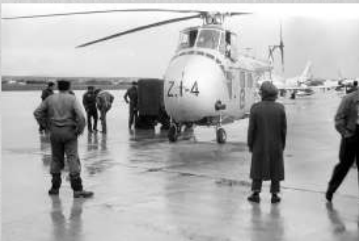
El Z.1-4 también participó activamente en las labores de rescate llevadas a cabo con motivo de la riada de Valencia del 14 de octubre de 1957. Obsérvese la cruz de San Andrés en el estabilizador vertical y la forma rectilínea del boom. Fuente: AHEA 161(09) DIG
