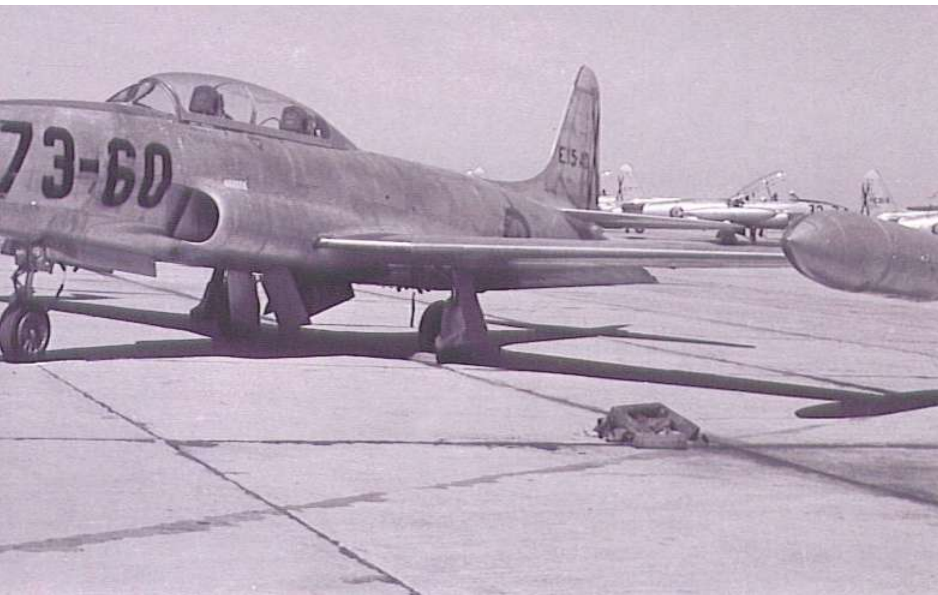
En esta perspectiva del E.15-40 (73-60) puede apreciarse que todavía no se le ha instalado el TACAN, pues no tiene la antena correspondiente delante de las puertas de la pata delantera del tren. (B.A. Talavera la Real, archivo del autor).
