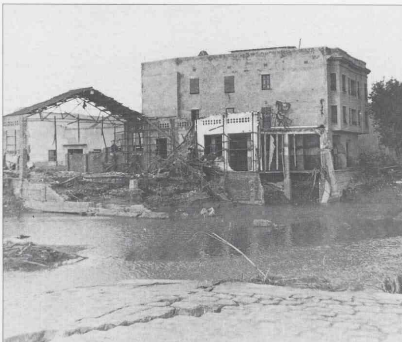
"Zona de Operaciones" del equipo de rescate del Ala de Caza nº 1 en el Puente de Campanar de la ciudad de Valencia, con ocasión de las inundaciones del 14 de octubre de 1957.
